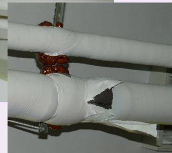
活動中心冰水管破裂
