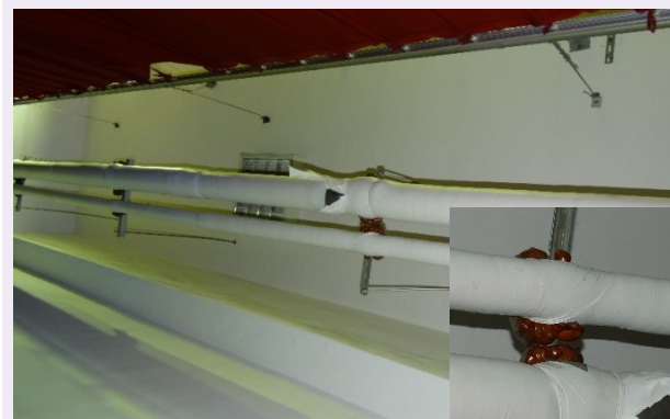
活動中心冰水管破裂
