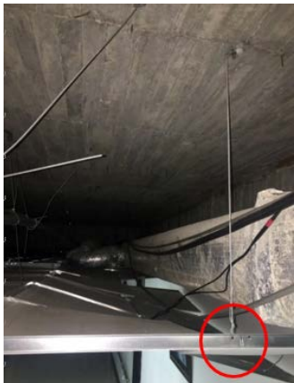
5樓走廊天花板
